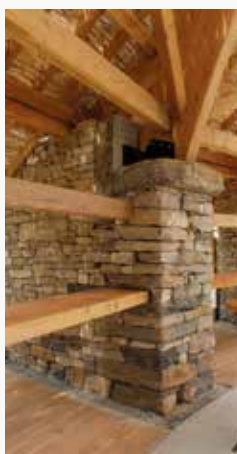
↑ Arco de madera laminada sobre capitel y machón de piedra en seco.
